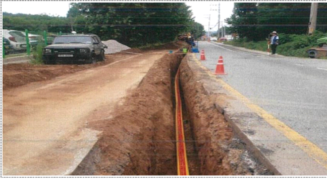
도시가스 관로 설치
