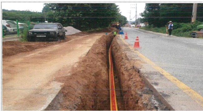
도시가스 관로 설치
